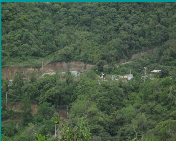
Instalaciones del proyecto Minero. Fotografía tomada desde el plantón de la Resistencia Pacífica de la Puya. Octubre 2015. Foto:PBI
